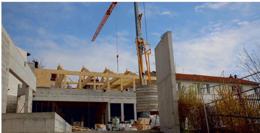
La charpente bois a été installée par l'entreprise Duché pendant les vacances de printemps. Elle a été suivie par la pose des tuiles et des menuiseries extérieures en mai. Le bâtiment est maintenant hors d'eau/hors d'air.
