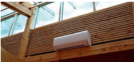
**A**près la réalisation d'une étude thermique, des unités de climatisation reliées à un système de pompe à chaleur ont été installées. L'objectif est de permettre de retrouver des températures intérieures adaptées lors des pics de chaleur. La réglementation préconise de ne pas avoir plus de 7° d'écart entre la température extérieure
